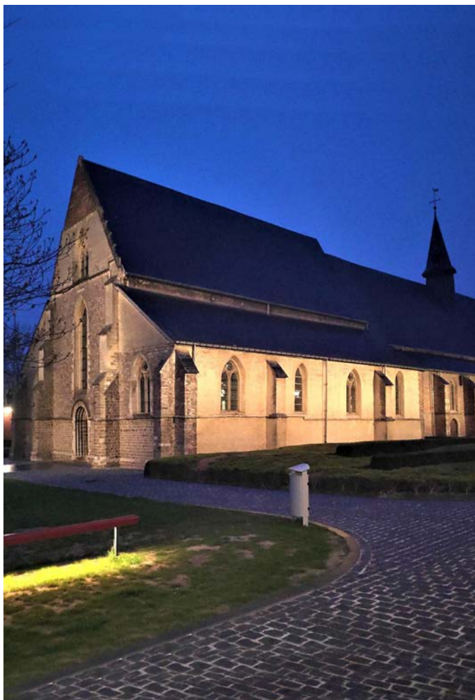
Begijnhofkerk, Sint-Truiden, Belgium. Luminaire: led.modular ©Hoffmeister
